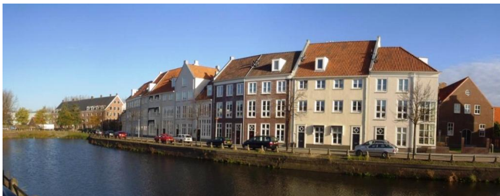
Foto: Noordzijde Haven
